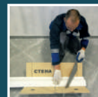
Монтаж лепного декора стр. 124
